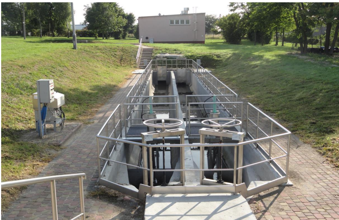
Zdjęcia terenu oczyszczalni ścieków w Kraśniku. (Źródło: Baza zdjęć KPWiK Sp. z o.o.)
