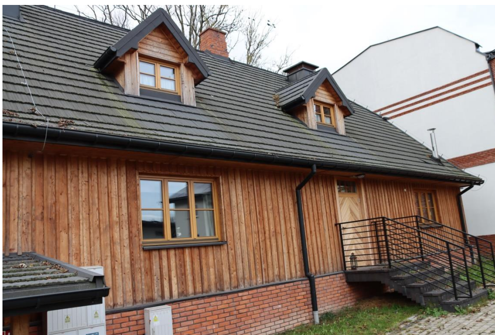
Zdjęcie 6. Szpital przykościelny tzw. dworek modrzewiowy przy ul. Narutowicza.
