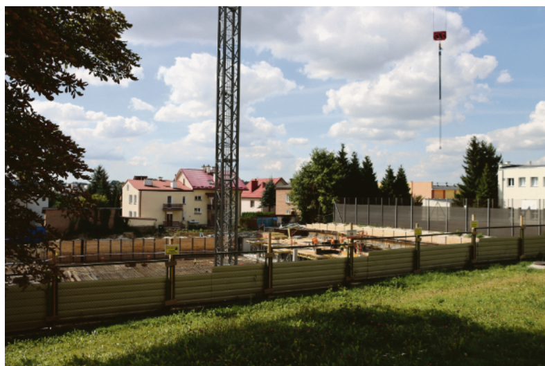
Budowa bloku firmy PBI.
