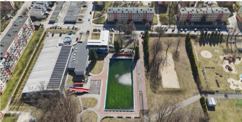
Po modernizacji krytej pływalni nadszedł czas na modernizację odkrytego basenu. Fot. J. Michalczyk
