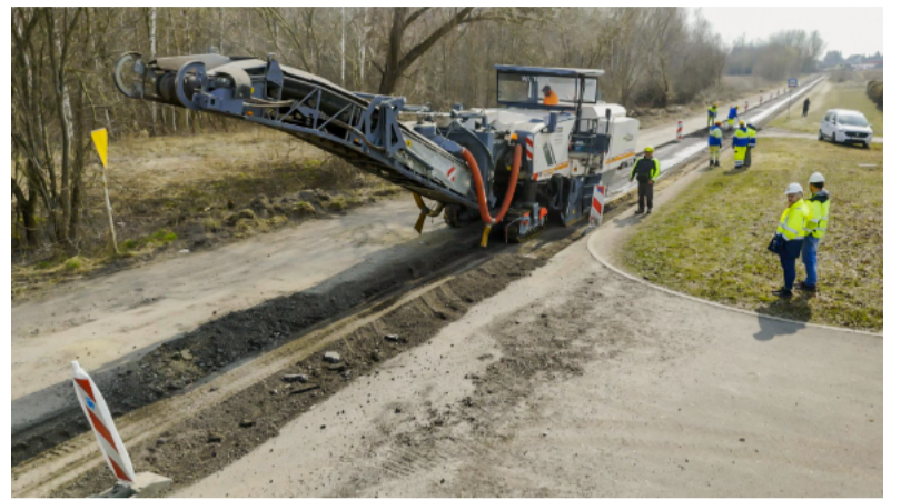
Budowa ulicy Obwodowej potrwa do października br. Fot. J. Michalczyk
